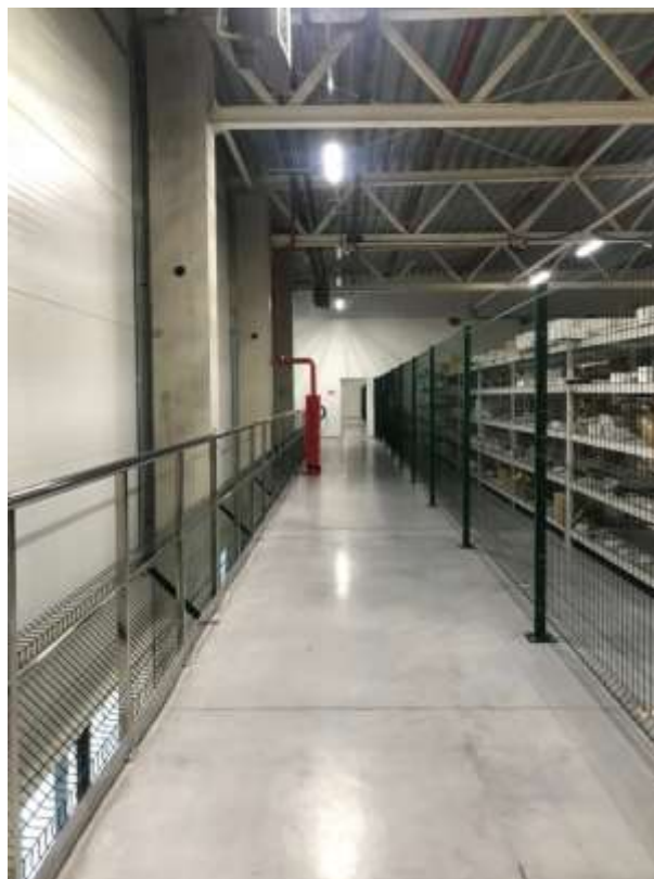
Фото № 14. Нежилое помещение оцениваемого здания
