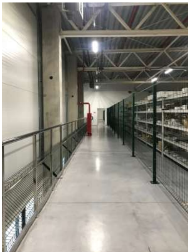
Фото № 14. Нежилое помещение оцениваемого здания
