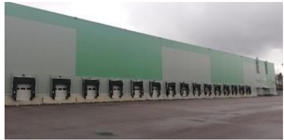
Фасад здания склада № 2
