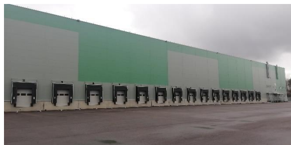
Фасад здания склада № 2
