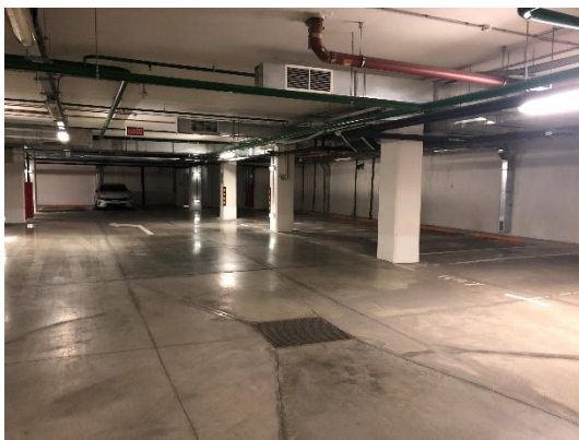
Подземный паркинг (на -5 этаже)
