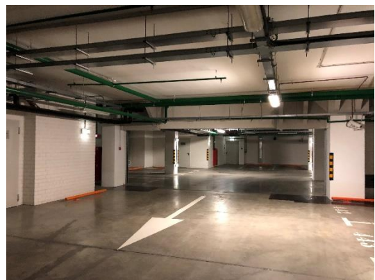
Подземный паркинг (на -4 этаже)
