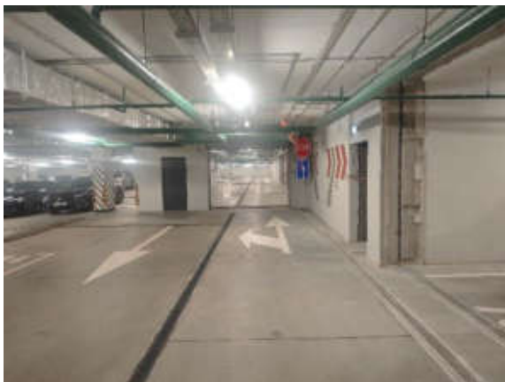
Подземный паркинг (на -1 этаже)
