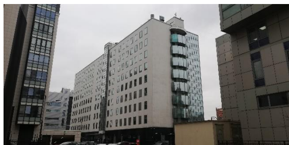
Торцевая и задняя сторона здания
