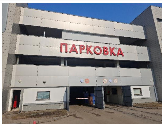
Въезд в здание автостоянки
