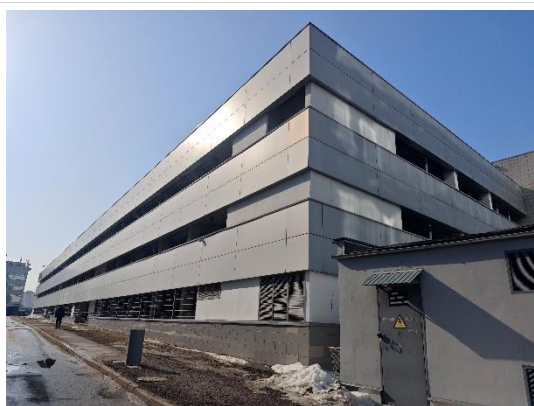
Фасад здания автостоянки
