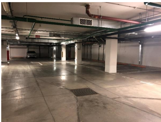
Подземный паркинг (на -5 этаже)
