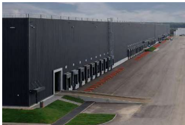
Фото № 2. Общий вид складского комплекса
