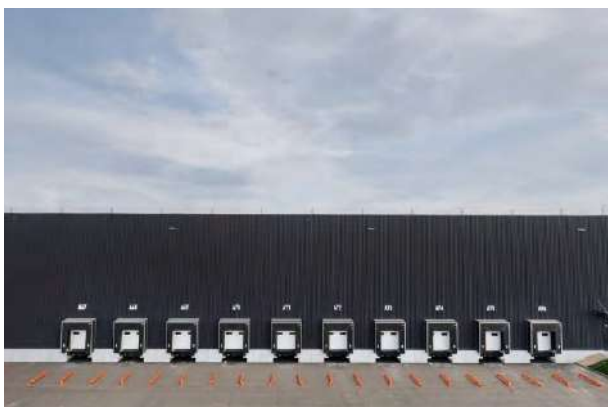
Фото № 5. Фасад здания
