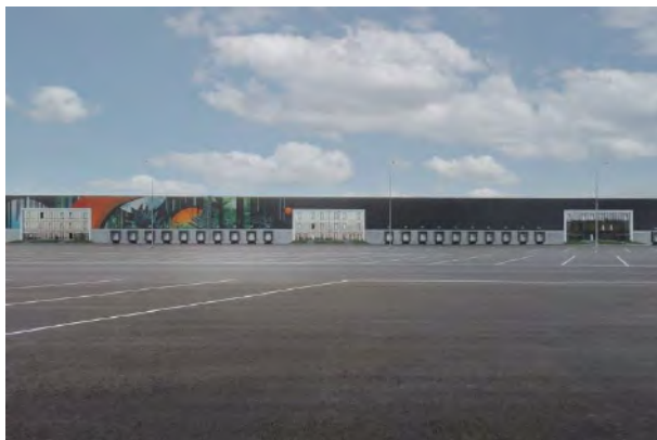
Фото № 4. Фасад здания
