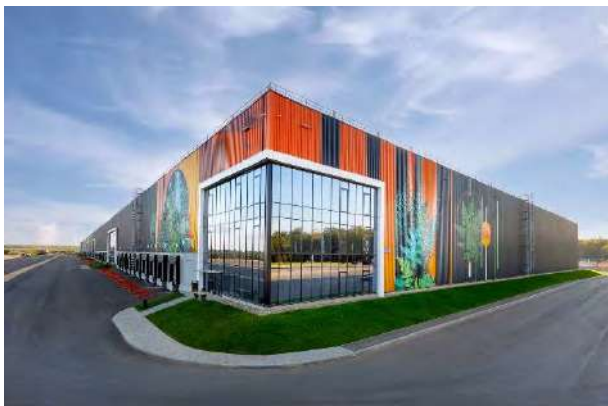
Фото № 3. Фасад здания
