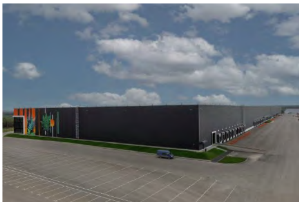
Фото № 1. Общий вид складского комплекса
