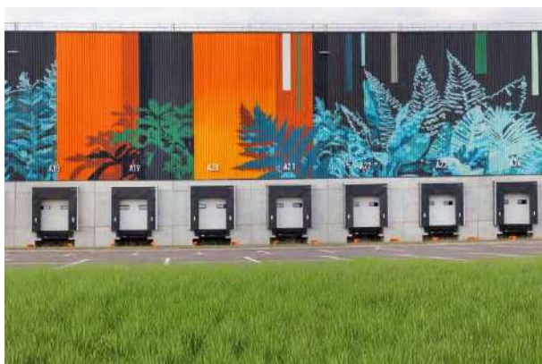
Фото № 6. Фасад здания
