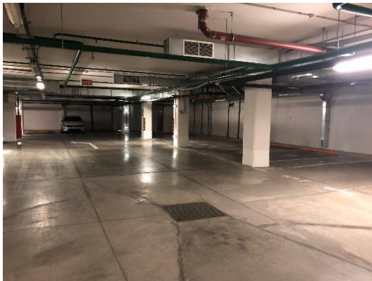
Подземный паркинг (на -5 этаже)
