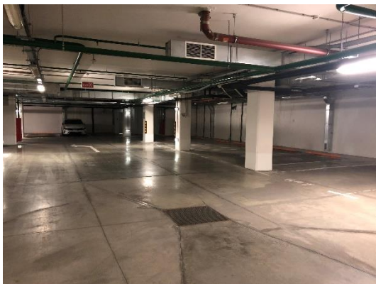
Подземный паркинг (на -5 этаже)
