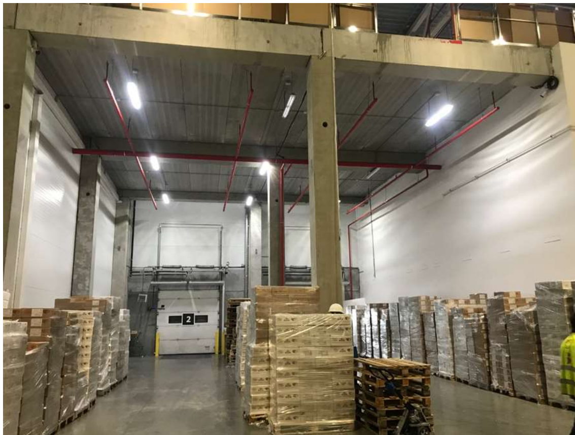
Фото № 12. Нежилое помещение оцениваемого здания
