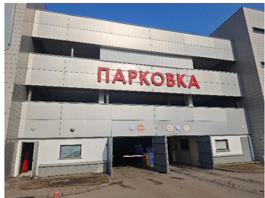
Въезд в здание автостоянки
