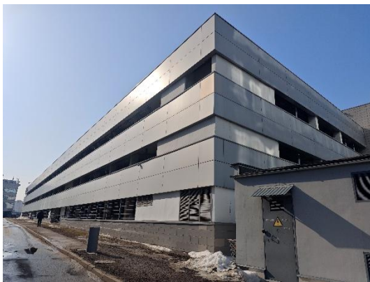
Фасад здания автостоянки
