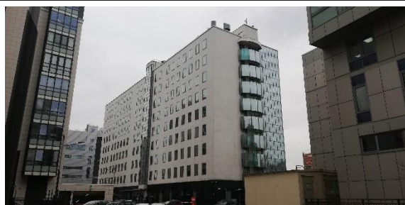
Торцевая и задняя сторона здания
