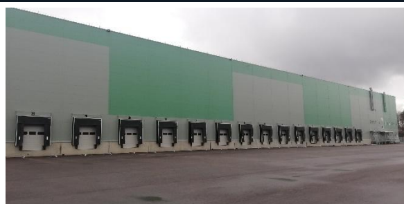
Фасад здания склада № 2
