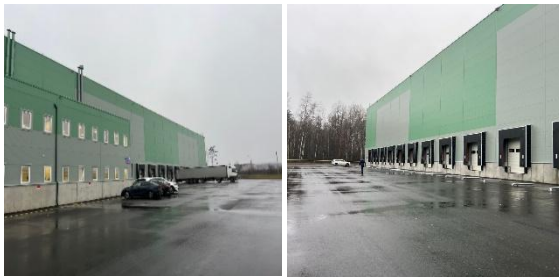
Фасады зданий склада № 1 и № 3
