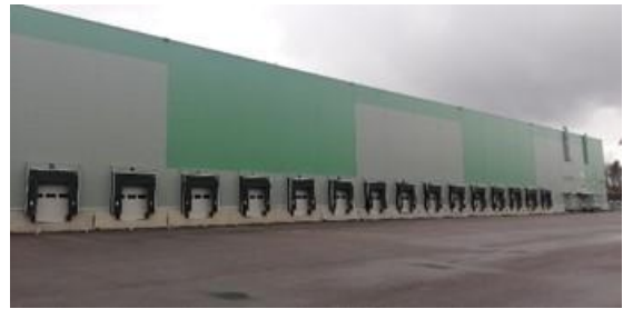
Фасад здания склада № 2
