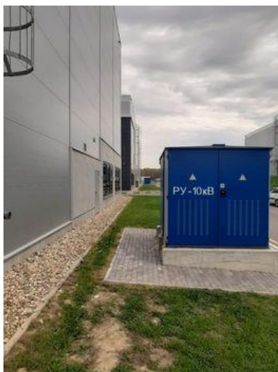
Фото № 3. Фасад здания
