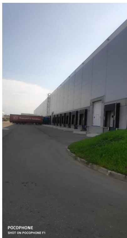
Фото № 22. Фасад здания
