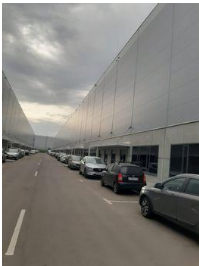
Фото № 1. Фасад здания
