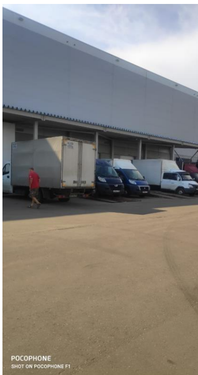
Фото № 26. Фасад здания
