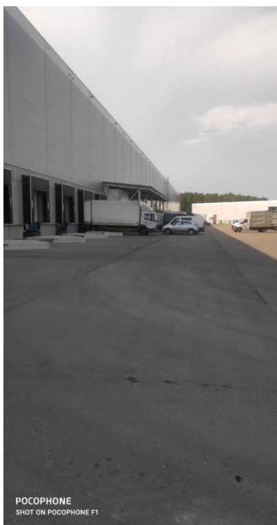
Фото № 29. Фасад здания
