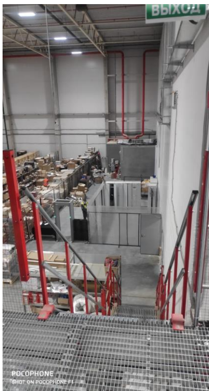
Фото № 37. Нежилое помещение
