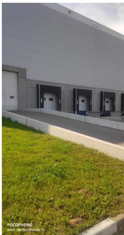
Фото № 23. Фасад здания
