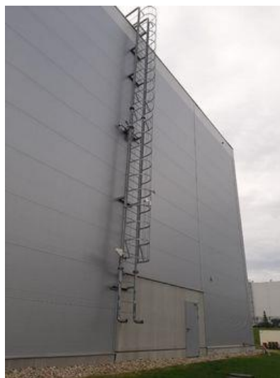
Фото № 4. Фасад здания
