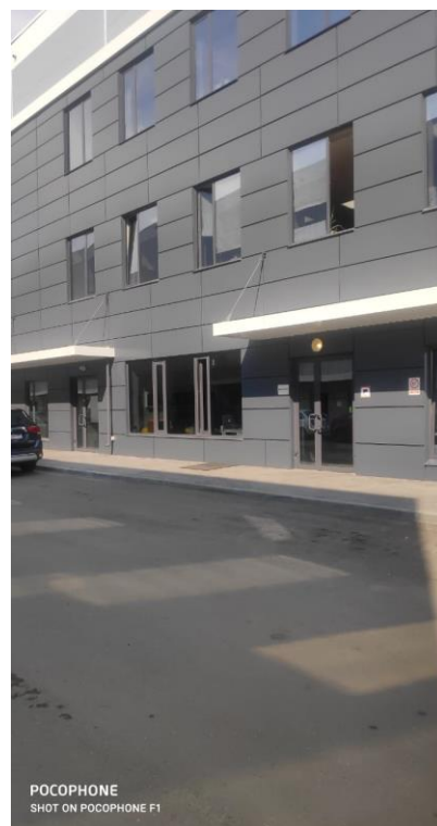
Фото № 24. Фасад здания
