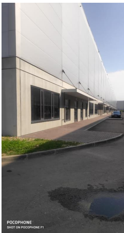
Фото № 28. Фасад здания
