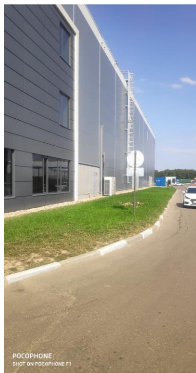
Фото № 30. Фасад здания
