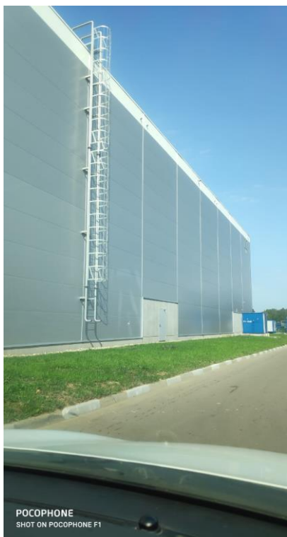
Фото № 25. Фасад здания
