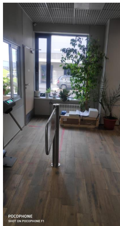
Фото № 57. Нежилое помещение
