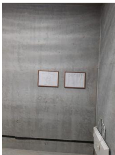
Фото № 6. Нежилое помещение
