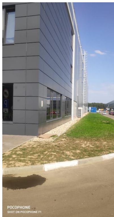
Фото № 27. Фасад здания
