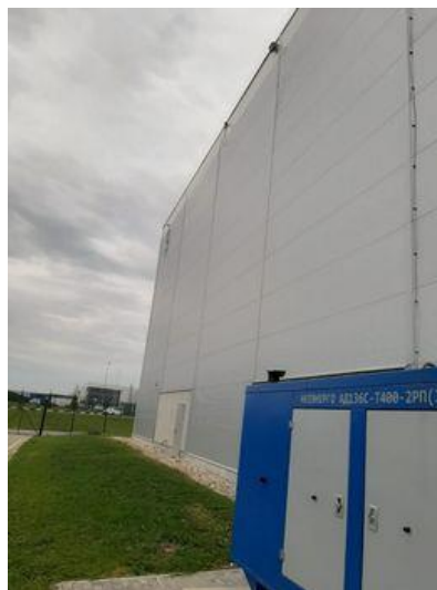
Фото № 2. Фасад здания
