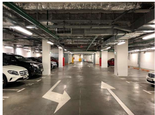
Подземный паркинг (на -1 этаже)
