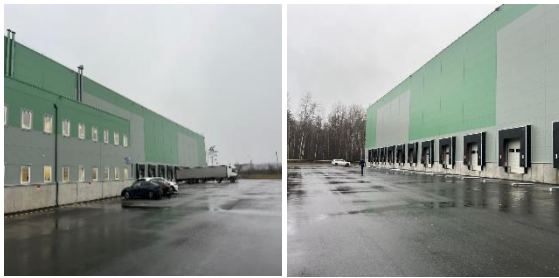
Фасады зданий склада № 1 и № 3
