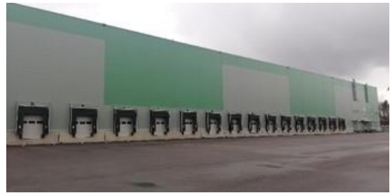
Фасад здания склада № 2
