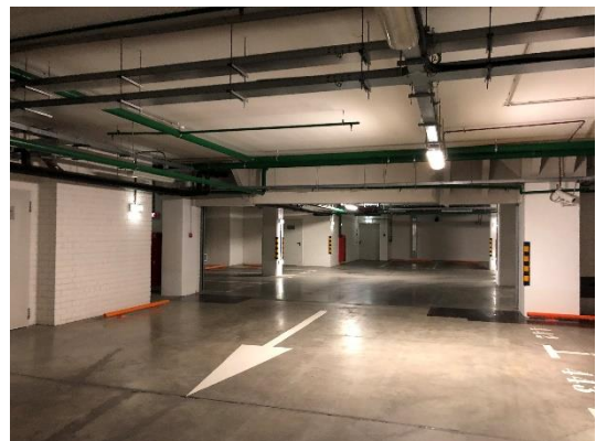
Подземный паркинг (на -4 этаже)
