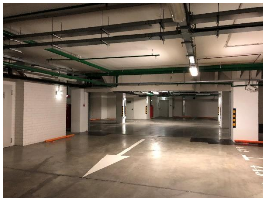
Подземный паркинг (на -4 этаже)
