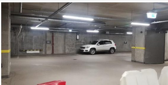
Подземный паркинг (на -2 этаже)
