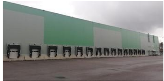
Фасад здания склада № 2
