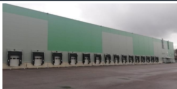
Фасад здания склада № 2
