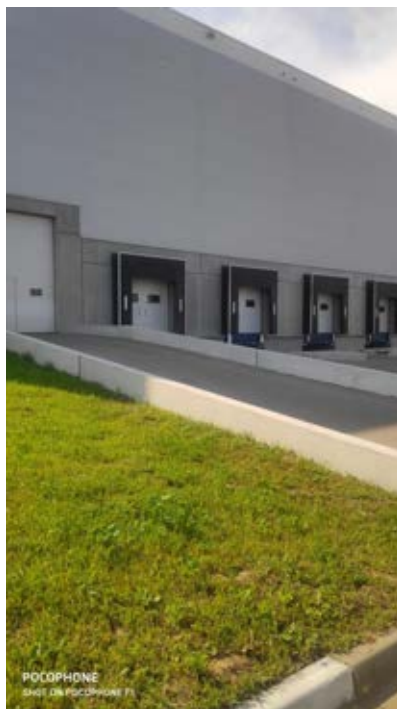
Фото № 23. Фасад здания
