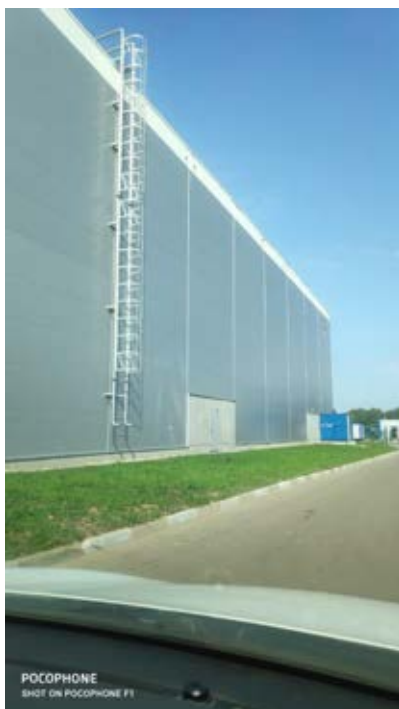
Фото № 25. Фасад здания
