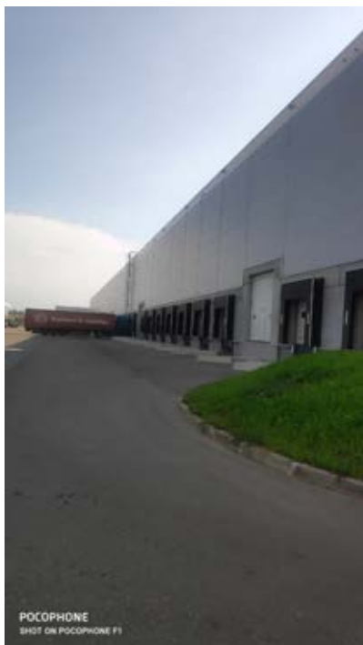
Фото № 22. Фасад здания
