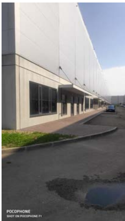
Фото № 28. Фасад здания
