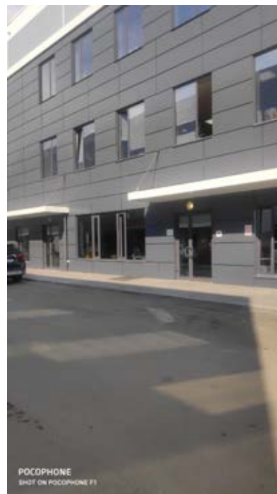
Фото № 24. Фасад здания
