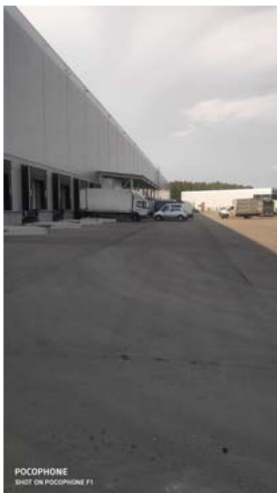
Фото № 29. Фасад здания
