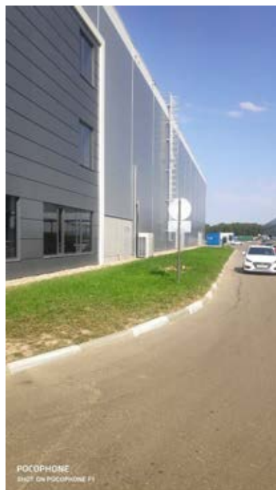
Фото № 30. Фасад здания
