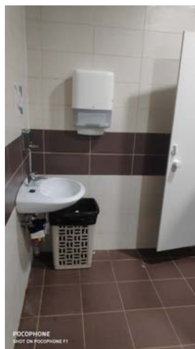
Фото № 51. Нежилое помещение
