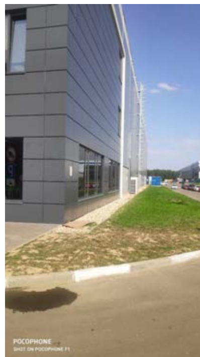
Фото № 27. Фасад здания
