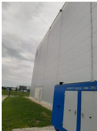
Фото № 2. Фасад здания
