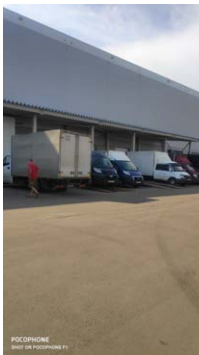
Фото № 26. Фасад здания
