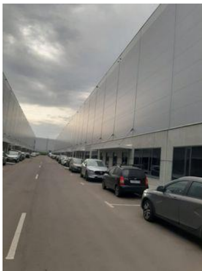
Фото № 1. Фасад здания
