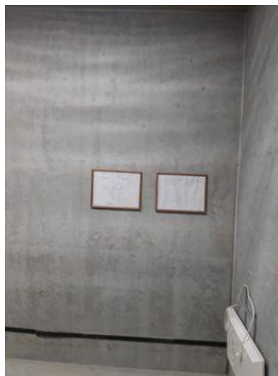
Фото № 6. Нежилое помещение
