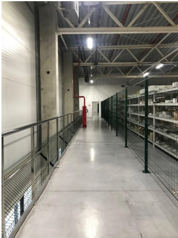
Фото № 15. Нежилое помещение оцениваемого здания
