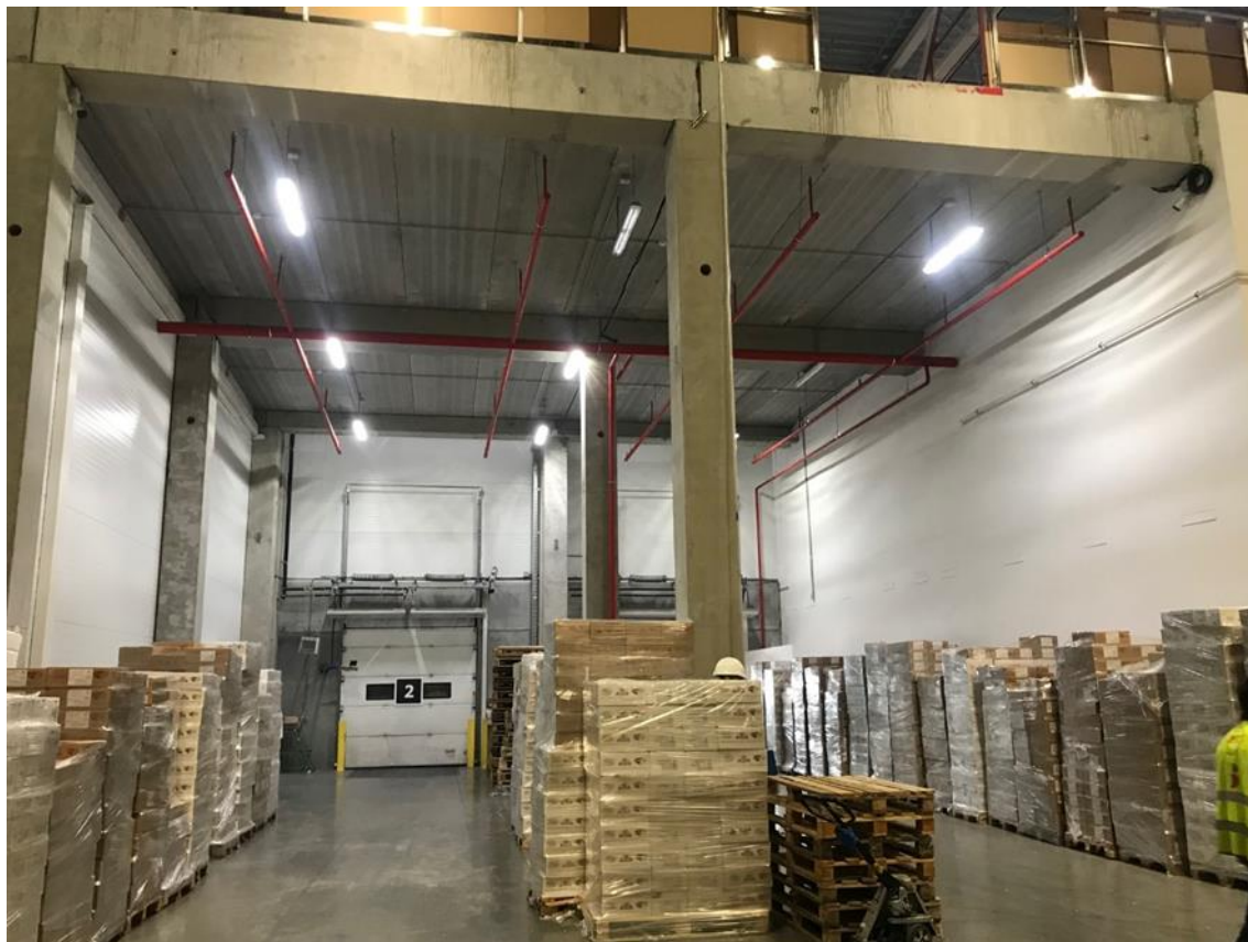
Фото № 12. Нежилое помещение оцениваемого здания
