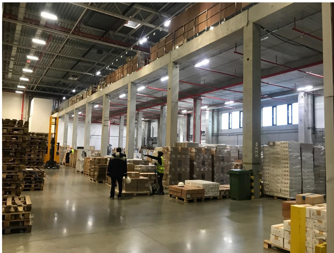
Фото № 13. Нежилое помещение оцениваемого здания
