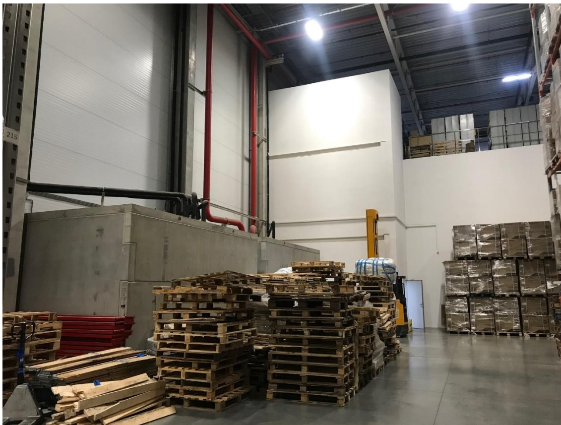
Фото № 9. Нежилое помещение оцениваемого здания
