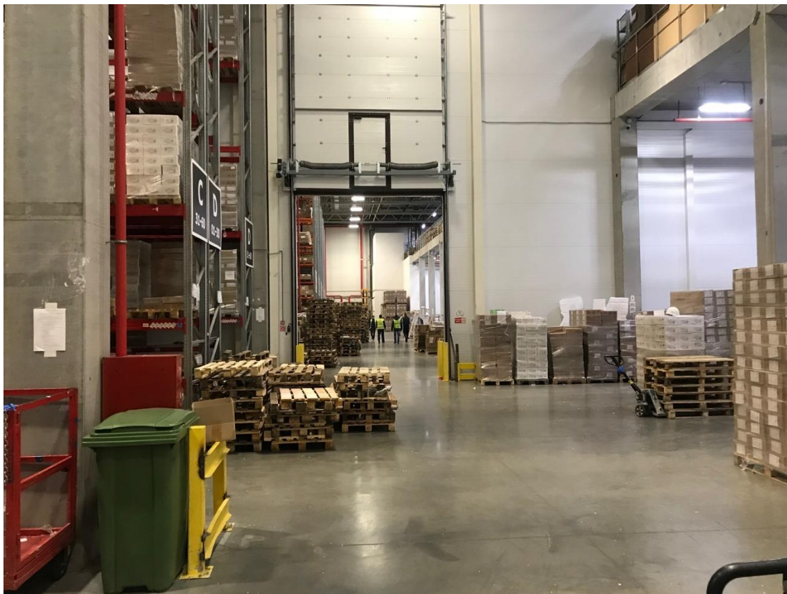
Фото № 10. Нежилое помещение оцениваемого здания
