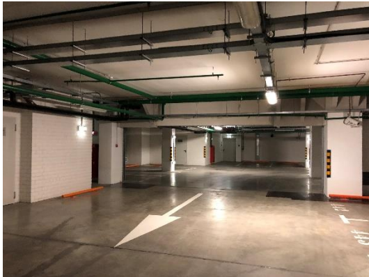
Подземный паркинг (на -4 этаже)
